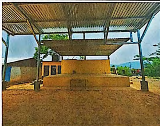
Foto 4: MEJORAMIENTO MODULO 5 (ESCENARIO), ESTRUCTURA DE TECHO
