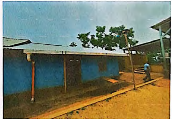
Foto 4: MEJORAMIENTO MODULO 11 Y 5, CANALES Y BAJADAS DE AGUA PLUVIAL
