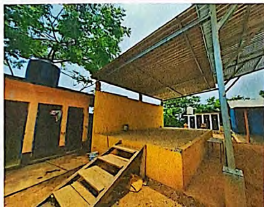
Foto 3: MEJORAMIENTO MODULO 5 (ESCENARIO), ESTRUCTURA DE TECHO
