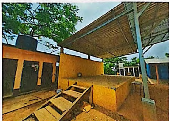
Foto 3: MEJORAMIENTO MODULO 5 (ESCENARIO), CUBIERTA DE LAMINA
