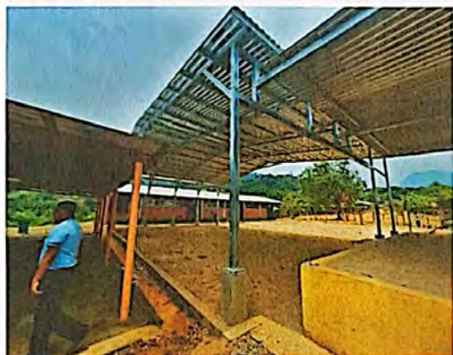
Foto 1: MEJORAMIENTO MODULO 5 (ESCENARIO), ESTRUCTURA DE TECHO
