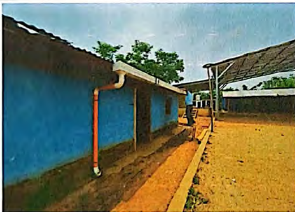
Foto 3: MEJORAMIENTO MODULO 11 Y 5, CANALES Y BAJADAS DE AGUA PLUVIAL
