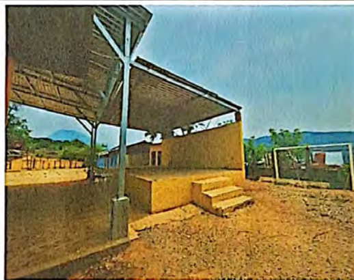
Foto 2: MEJORAMIENTO MODULO 5 (ESCENARIO), ESTRUCTURA DE TECHO
