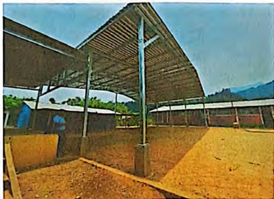
Foto 1: MEJORAMIENTO MODULO 5 (ESCENARIO), CUBIERTA DE LAMINA
