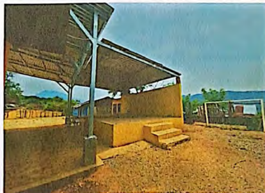
Foto 2: MEJORAMIENTO MODULO 5 (ESCENARIO), CUBIERTA DE LAMINA
